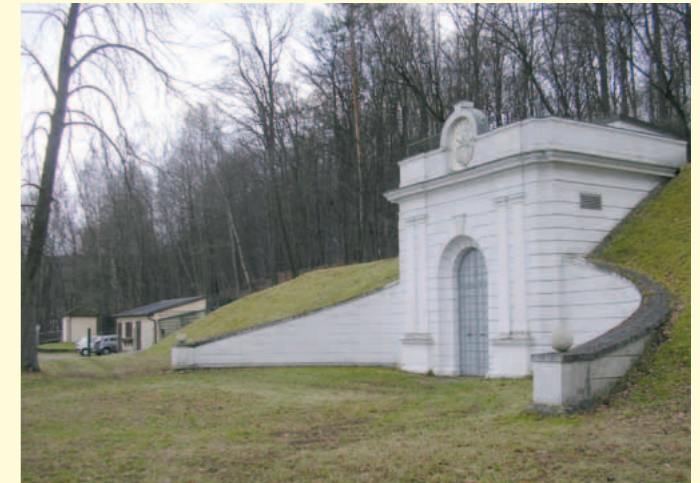
Zugang des Hochbehälters Am Anger „heute“
