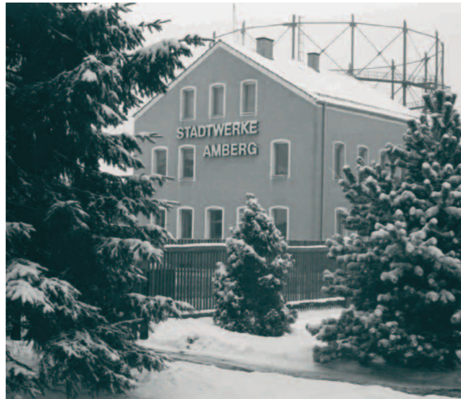
Stadtwerke, Technische Abteilung
