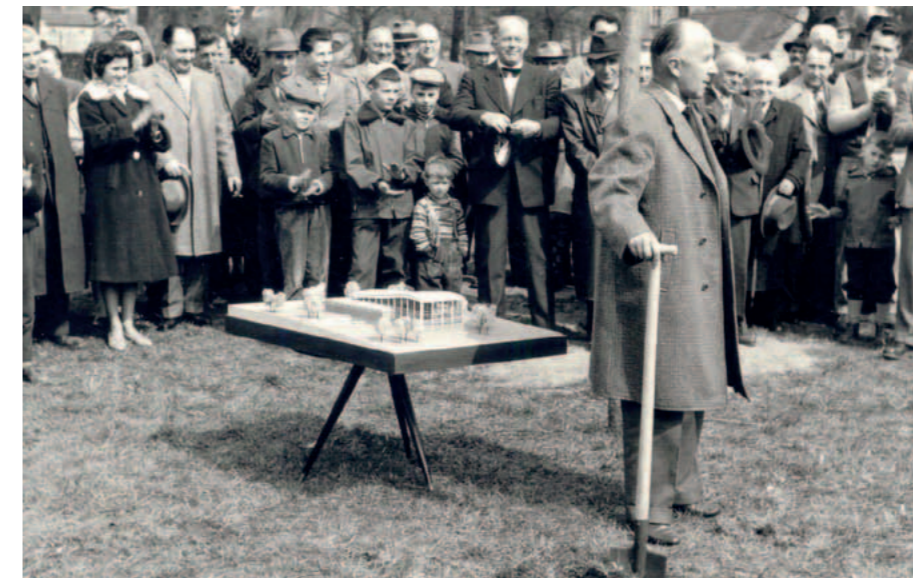
Erster Spatenstich zum Bau des Amberger Hallenschwimmbades am 30. März 1960 durch OB Steiningger
