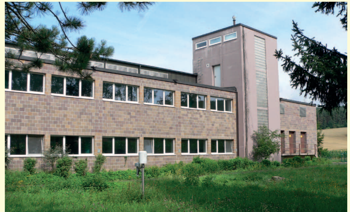
Wasserwerk in Engelsdorf, 2007
