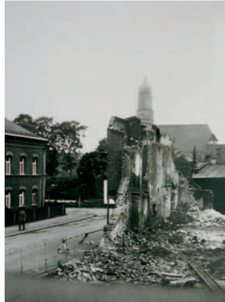
Kokerei, Abbruch des Ofenhauses
