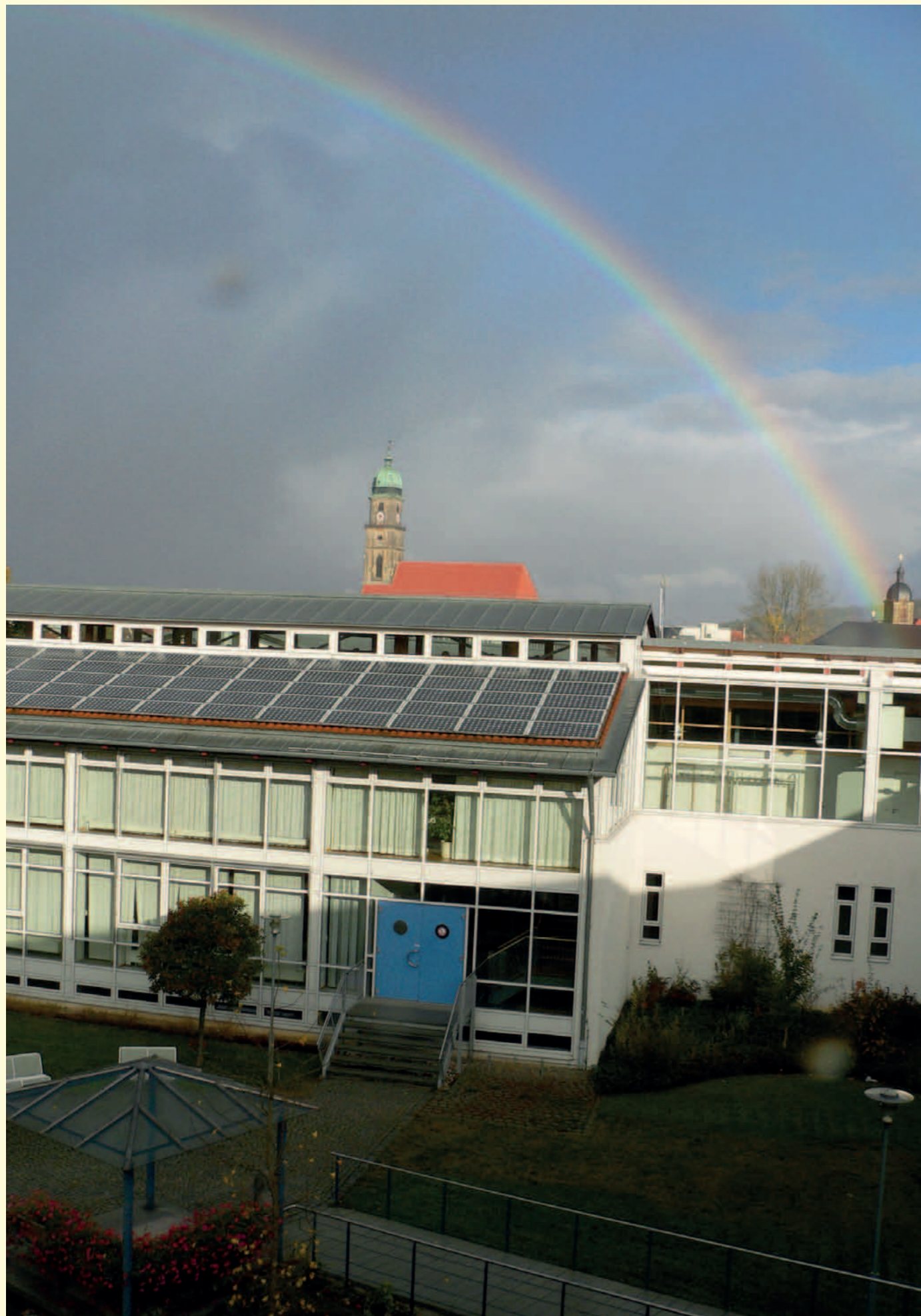
Verwaltungsgebäude der Stadtwerke mit Sicht auf die Photovoltaikanlage
