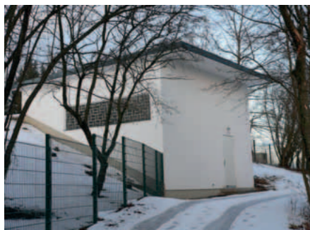
Hochbehälter Südhang „außen“
