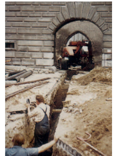
Wasserleitungsbau am Wingershofer Tor
