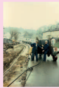
20 kV-Verlegung Sulzbacher Straße – Anbindung Umspannwerk Luitpoldhöhe an die Stadt
