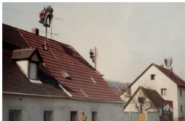
Abbau eines der letzten Dachständer, Pfistermeierstraße
