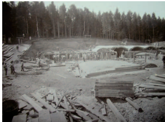
Errichtung des Hochbehälters Am Anger
