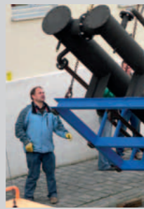
Einbau des BHKW-Motors im Raseliushaus
