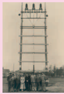
Bleichwiese, 20 kV-Freileitungsgestütz
