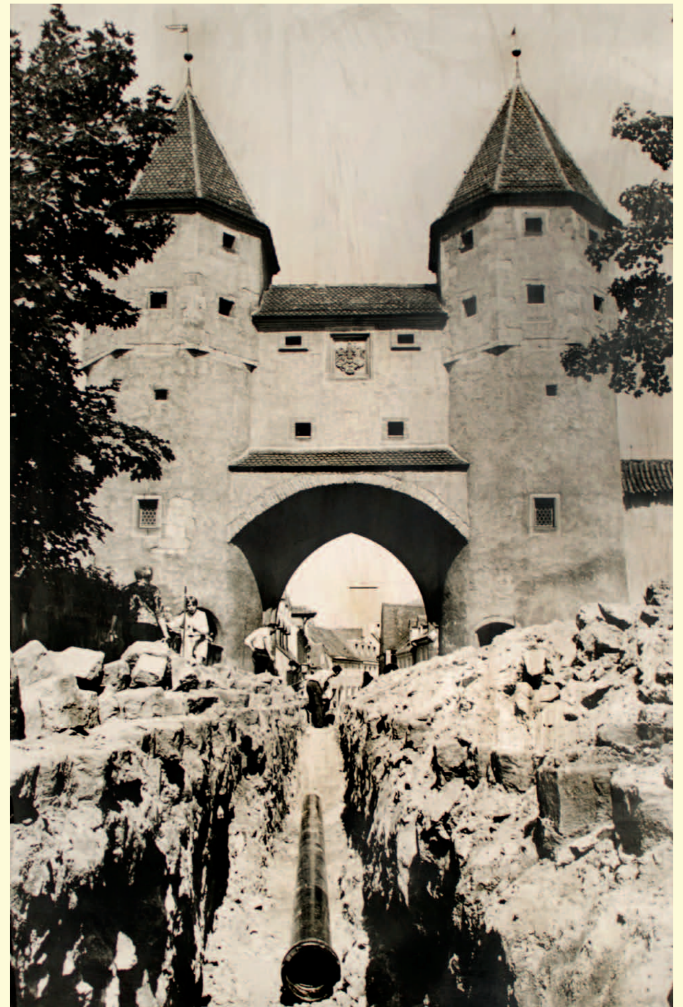
Gasleitungsneubau am Nabburger Tor
