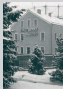
Stadtwerke, Technische Abteilung
