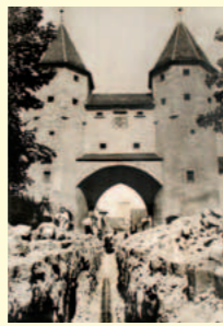
Gasleitungsneubau am Nabburger Tor
