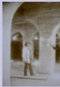
Hochbehälter Am Anger
